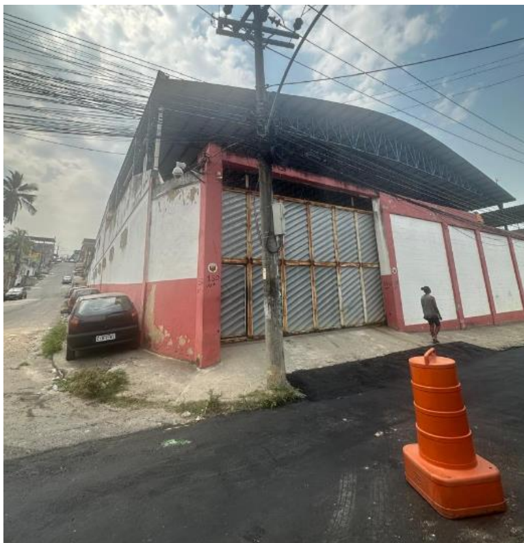
Galpão 1 - Fachada da sede
